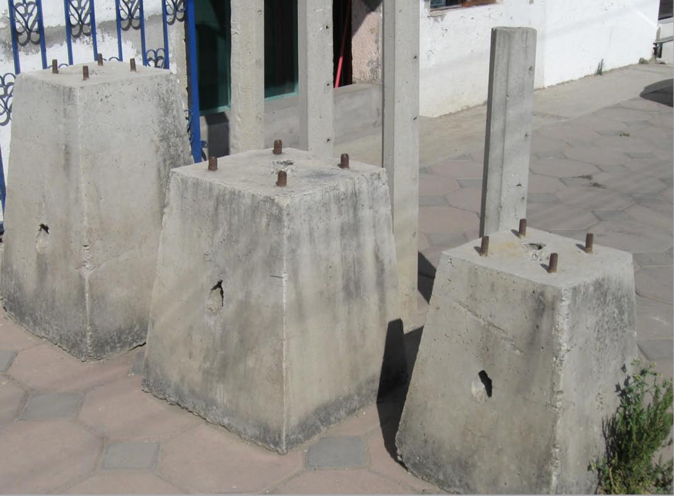
Bases de Concreto
